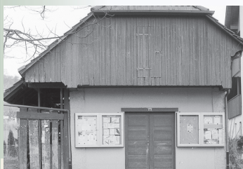
Altes Turnlokal in der Schulstrasse, Foto 2002
